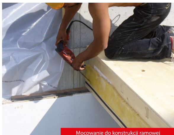
Mocowanie do konstrukcji ramowej
