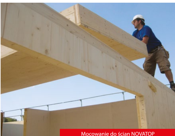
Mocowanie do ścian NOVATOP
