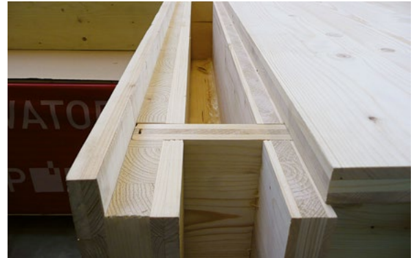
Zamknięcie widocznego wycięcia za pomocą litej płyty.
