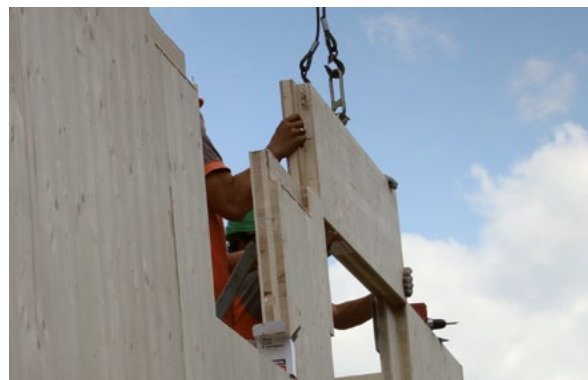
Przygotowanie złączy i montaż – SOLID 84, 124 mm.
