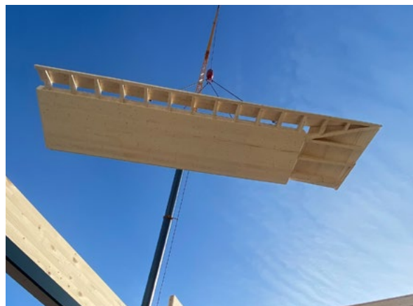
Prefabrykacja indywidualna NOVATOP OPEN.
