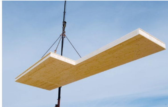
Wycięcie w obszarze elementu powyżej 3 m 2 .
