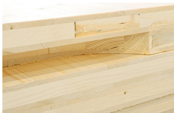
Frez walcowy – możliwość frezowania od spodu (maksymalna głębokość 100 mm od krawędzi).
