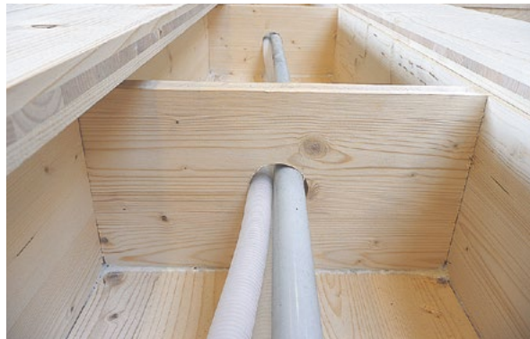
Wiercenie otworów w żebrach pod instalację.
