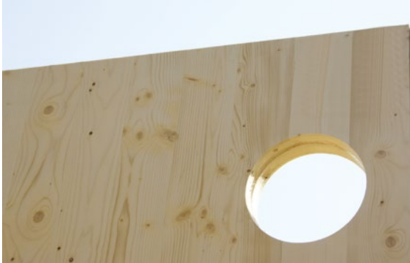
Frezowanie okrągłych otworów.
