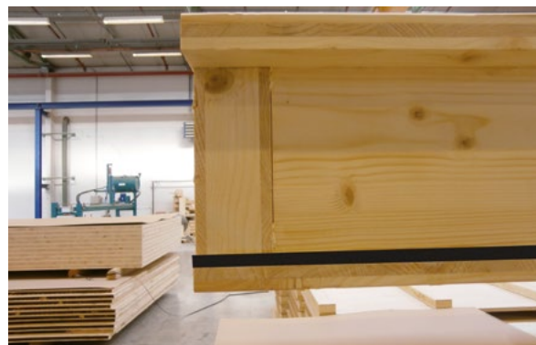
Instalacja taśmy ogniochronnej w złączu wzdłużnym.
