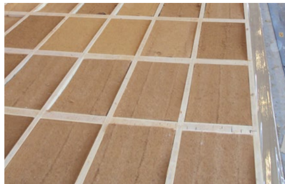
Wypełnienie izolacją z włókna drzewnego.
