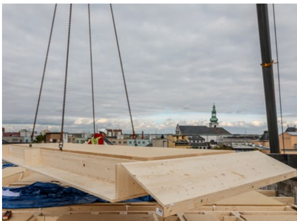
Prefabrykacja indywidualna NOVATOP OPEN.
